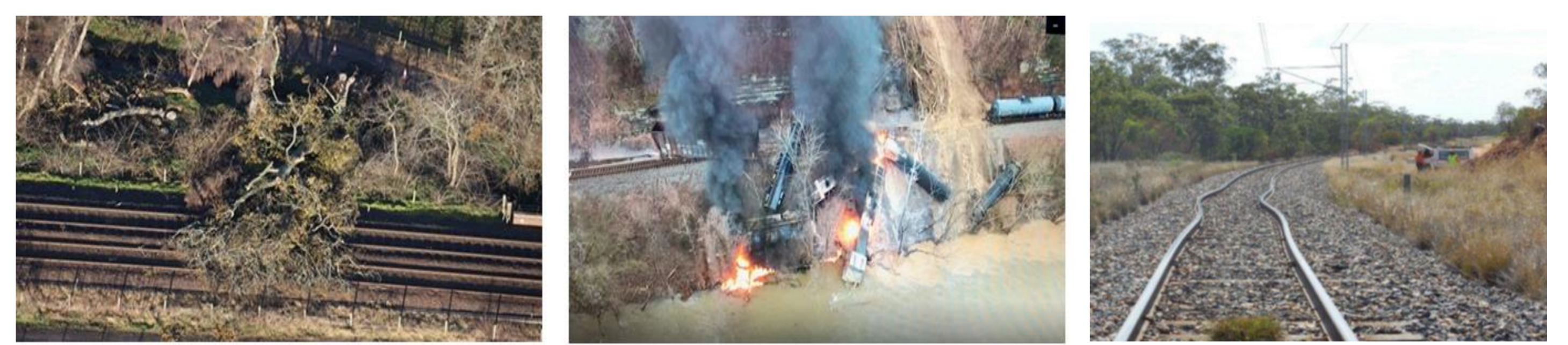
Beispiele für Störungen der kritischen Bahninfrastruktur: (links) Umgestürzte Bäume blockieren Gleise nach Sturmereignis, (Mitte) Folgen des Eisenbahnunglücks bei Elkhorn City (Kentucky), verursacht durch Erdbeben, (rechts) Beispiel einer Gleisverwerfung, Australien
